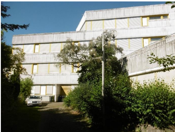
Abbildung 15 Hauptgebäude von Süden, links Hausmeisterwohnung
