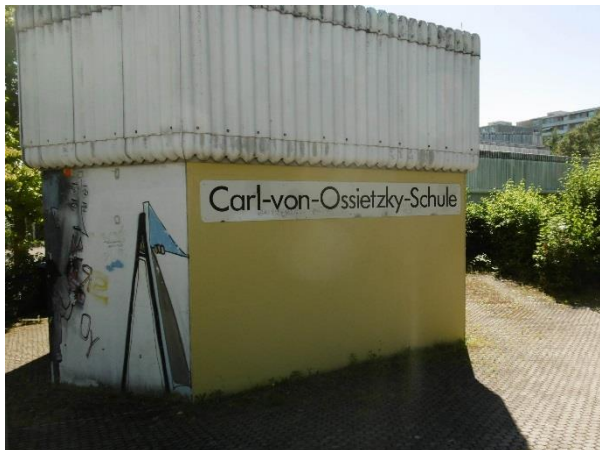
Abbildung 7 Haupteingang von Norden
