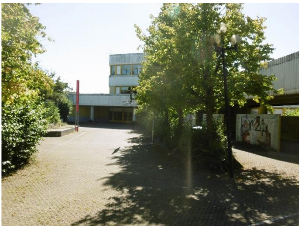
Abbildung 11 Haupteingang von Norden
