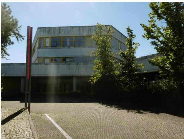
Abbildung 9 Haupteingang von Norden
