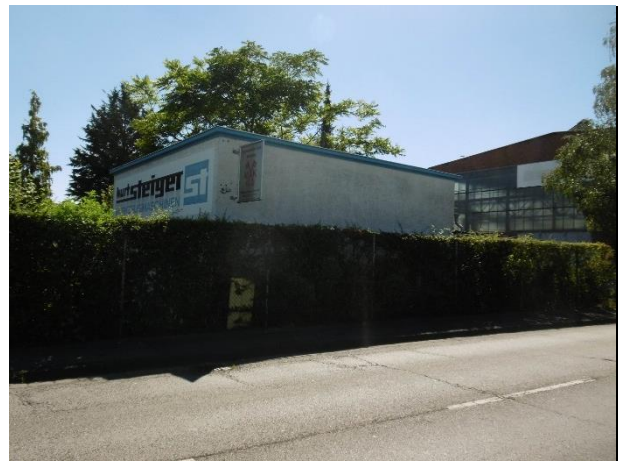
Abbildung 36 Metallbaubetrieb, südlich Hessenwasser
