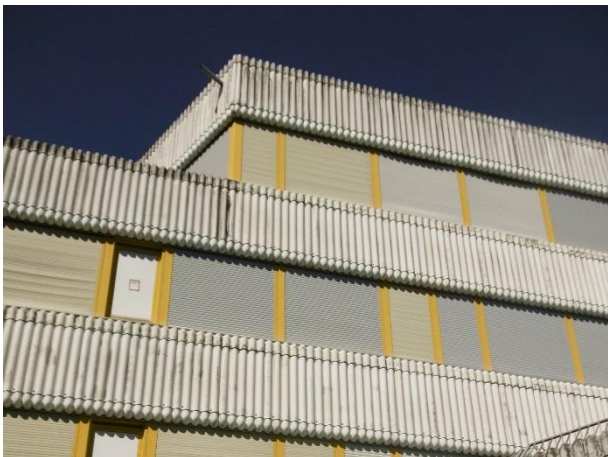
Abbildung 17 Hauptgebäude von Süden
