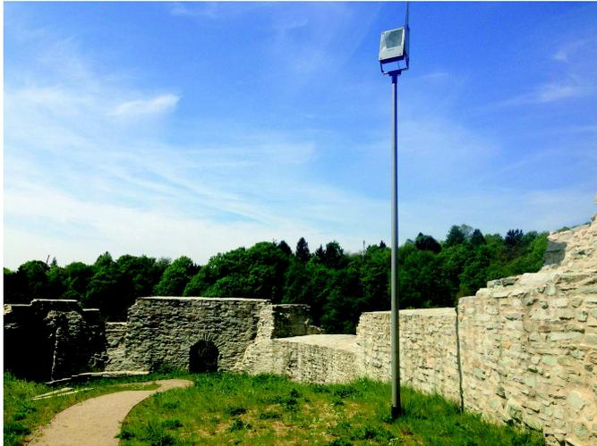
Die bereits sanierte Nordmauer mit Ergänzungen im aufgehenden Bereich; diese wurden mittels Bleistreifen vom historischen Mauerwerk getrennt.
