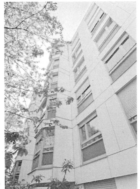
Blick auf die Westfassade von der Terrasse im 2.UG
