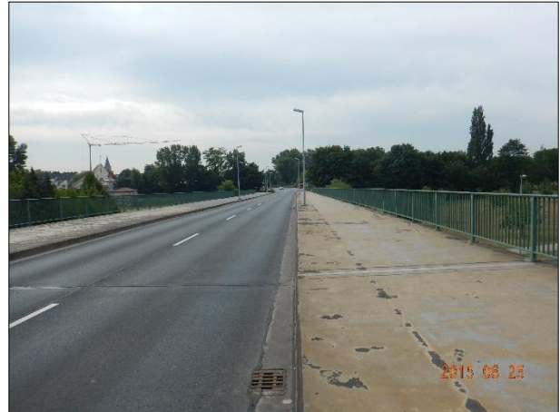
Vorlandbrücke – Blick in Richtung Gustavsburg
