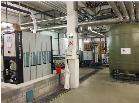
GFK-Filterbehälter und Chlor-Elektrolyseanlage
