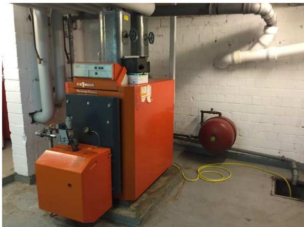
Heizkesselanlage 80 KW
