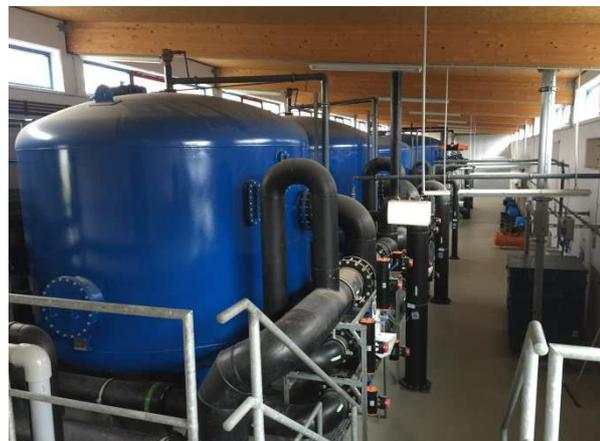
Umwälzanlagen als Stahldruckfilter
