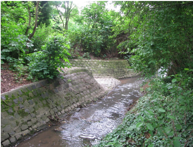
Abbildung: Einleitung Regenüberlauf im Bereich Berliner Straße in den Wäschbach (Götte Landschaftsarchitekten GmbH, 2013)
