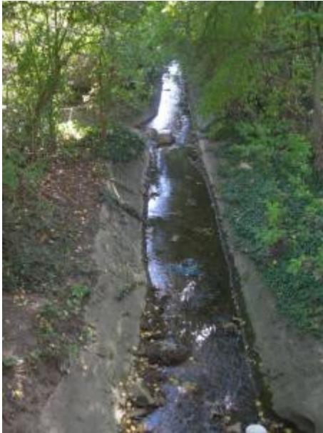
Abbildung: Verlauf des Wäschbachs im Trapezprofil (Götte Landschaftsarchitekten GmbH, 2013)
