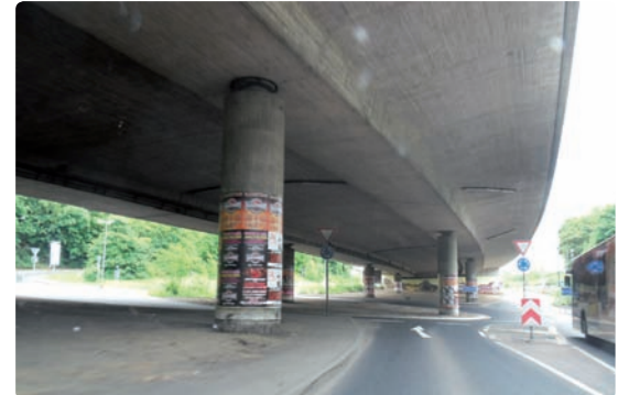
Eisenbahnbrücke an der Schiersteiner Straße
