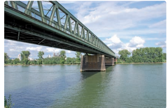
Eisenbahnbrücke Mainzer Straße
