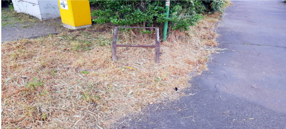
Abbildung 1: Im Bereich des Briefkastens/der Leihradstation befindet sich am Parkeingang eine verrostete Halterung für ein ehemaliges Schild. Diese soll entfernt werden.
