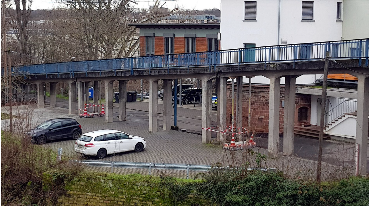
Abbildung 1: Blick auf das Gelände der Wasserschutzpolizei auf der Maarau. Die zusätzlichen Stützen sind mit Flutterband und Pylonen abgesperrt.
