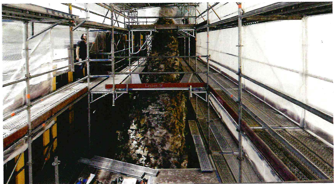
Abb. 17: Aktuelle Einhausung der Heidenmauer für die Restaurierung der Steinoberflächen. Foto: Ch. Kayser, Barthel & Maus
