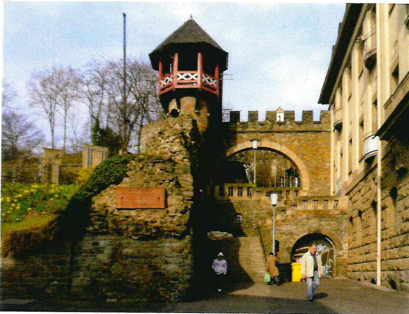
Abb. 1: Blick von der Altstadt auf die „Heidenmauer“ am Hang des Schulbergs. Der Treppenaufgang entstand um 1902 beim Durchbruch der Coulinstraße. Foto: Ch. Kayser, Barthel & Maus
