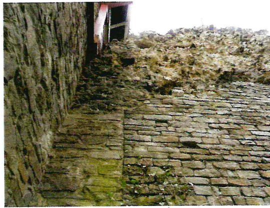
Abb. 16: Baufuge im Nordosten des Römertores. Rechts unten die Untermauerung von 1880, links unten das 1902 ergänzte Mauerwerk des Römertores, oben das antike Mauerwerk der Heidenmauer. Foto: Ch. Kayser, Barthel & Maus
