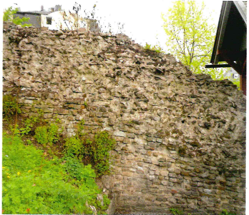
Abb. 7: Südseite der Hangmauer mit gut ablesbaren Befunden zur Bautechnik: Im unteren Teil ist die Handquaderschale erhalten, oberhalb im Kernmauerwerk zeichnen sich die Betonierabschnitte deutlich ab; auch die durchgehenden Rüstlöcher sind gut zu erkennen.
