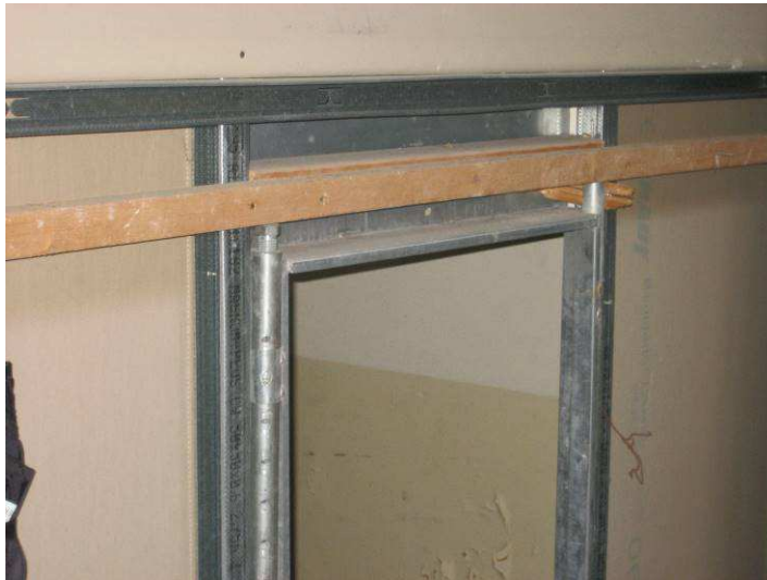
Foto 10) Treppenraumabtrennung Hochstättenstraße 1. OG
